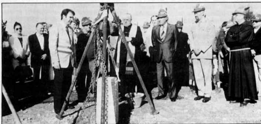
Posa della prima pietra della Baita alpina.
