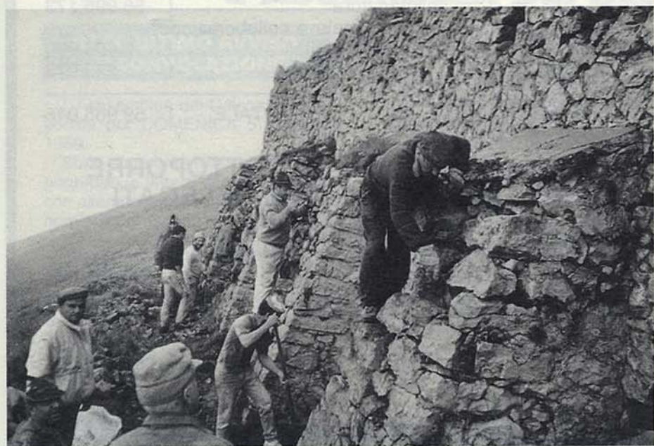
Consolidamento statico del muro.
