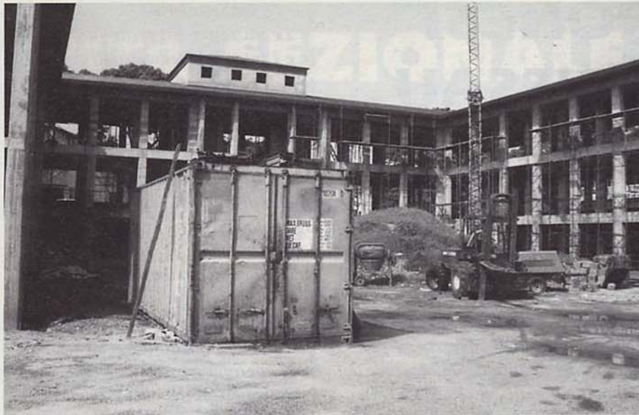
Il Centro Sociale in via di costruzione, al quale hanno destinato il loro contributo gli Alpini veronesi.
