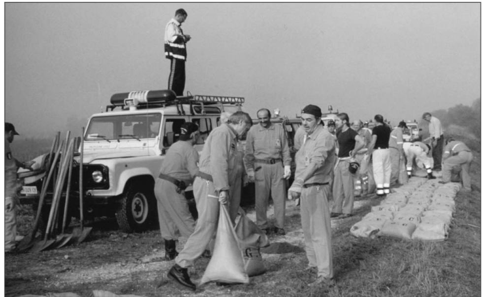
Volontari della Protezione civile posizionano sacchi di sabbia per costruire una difesa arginale (sopra soglia) coordinati da tecnici del Genio Civile
