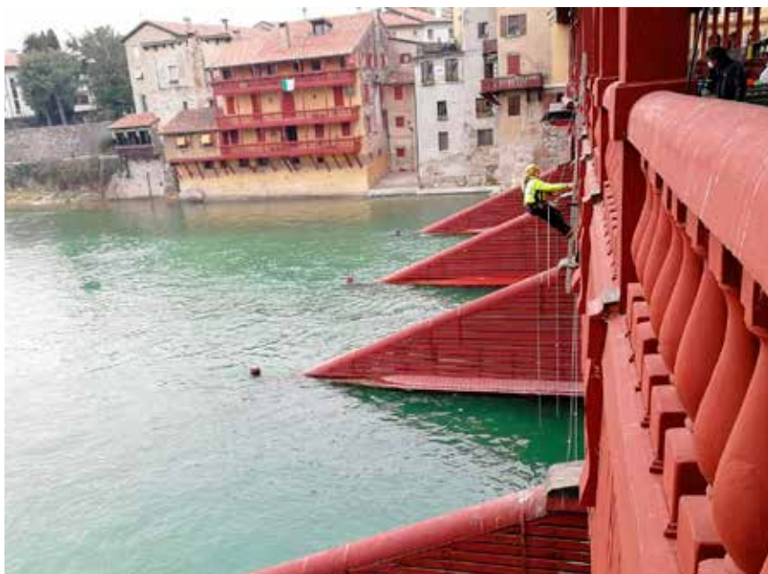
Ponte di Bassano
